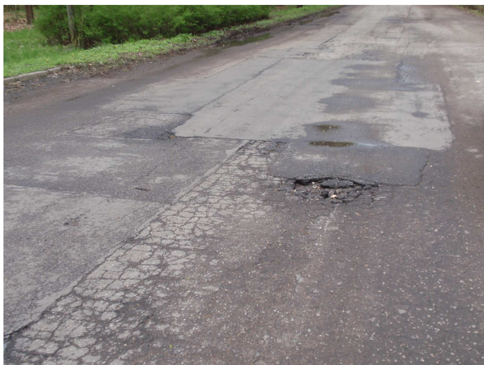
Zdjęcie 10 – stan nawierzchni na ul. Na Leszkowie (na wysokości cmentarza)
