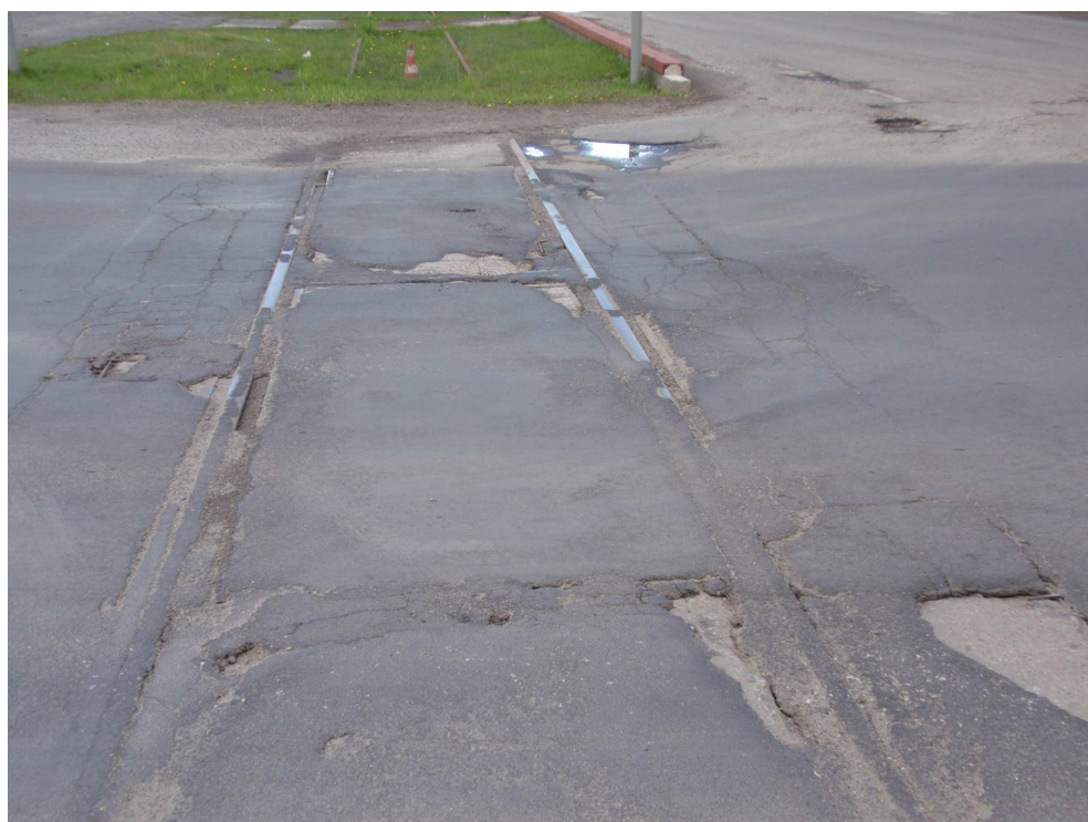
Zdjęcie 56 – tory boczny kolejowej zalane asfaltem na szerokości jezdni
